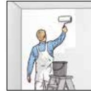
**3a.** Bei glatten Untergründen ERFURT-Systemkleber SR 2 mit einer langflorigen Walze bahnenweise satt auf den Untergrund aufrollen.
