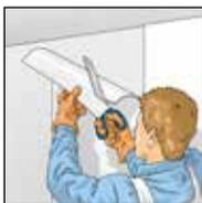
**6.** Überstände an Decken, Fußleisten, Fenstern usw. mit einer starken Schere oder mit einem Hakenklingelmesser und dem Spachtel abtrennen.
