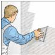
**3b.** Bei leicht bis mittel strukturierten Untergründen ERFURT-Systemkleber SR 4 mit einem Zahnpachtel (B2 oder C3, je nach Untergrund) gleichmäßig quer zur Laufrichtung direkt auf die Wandfläche auftragen.
